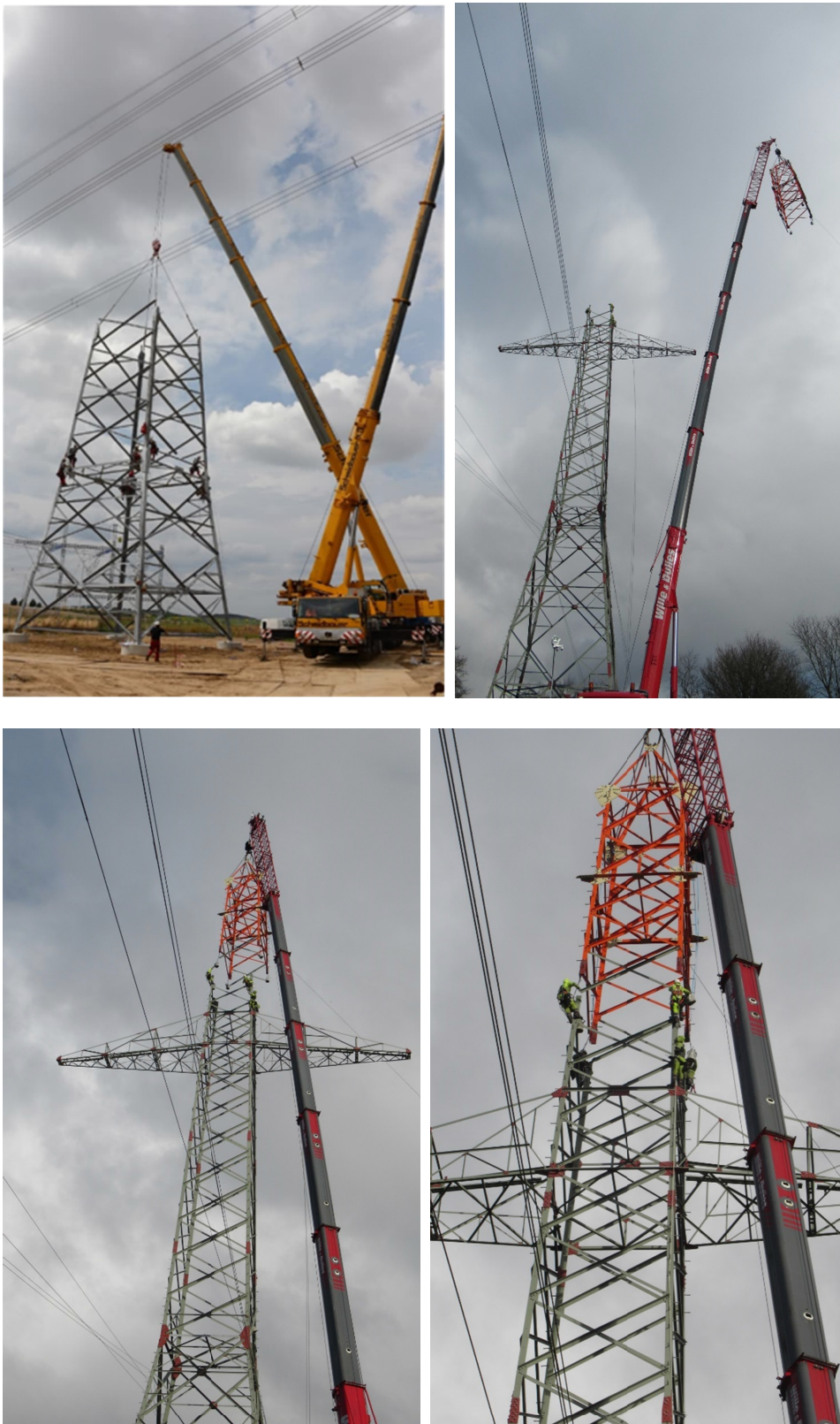
Abbildung 45: Maststockung mit Mobilkran
