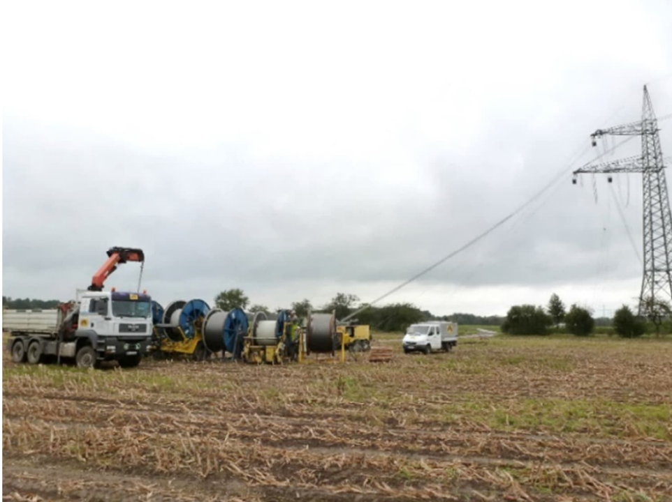
Abbildung 55: Trommelplatz und Seilzugarbeiten
