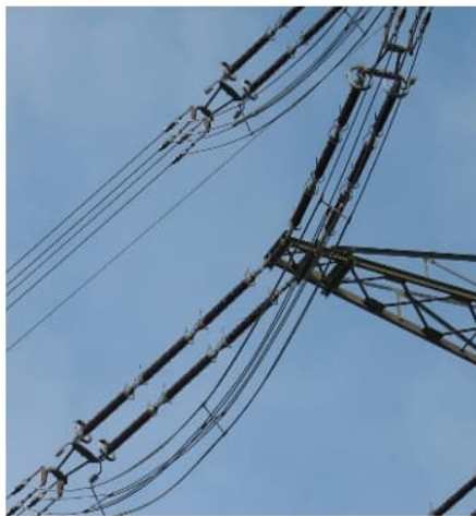
Abbildung 39: Isolatorketten am Abspannmast
