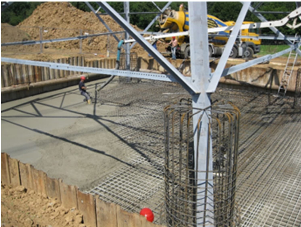
Abbildung 42: Betonierung eines Plattenfundament
