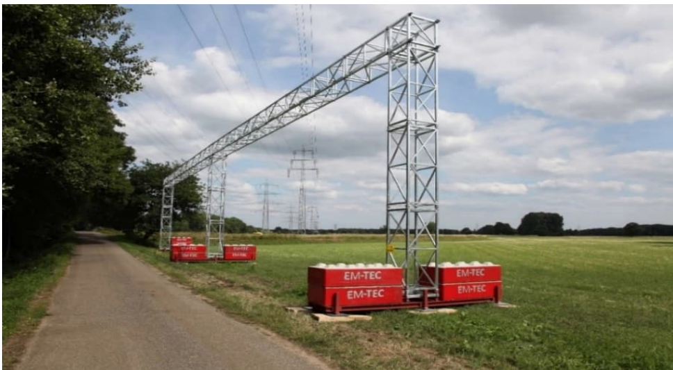
Abbildung 47: Beispiel Schutzgerüst mit Betonauflastgewichten
