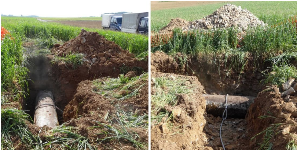
Abbildung 51: Beispiel „Totmann-Anker“ während des Einbaus
