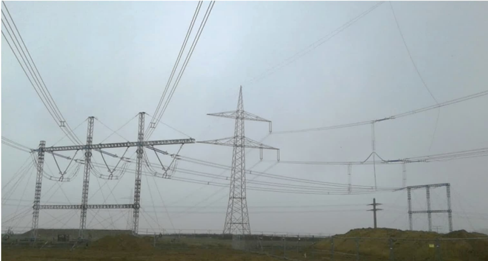
Abbildung 63: 380-kV-Provisorium mit mehrstieligen Portalmasten
