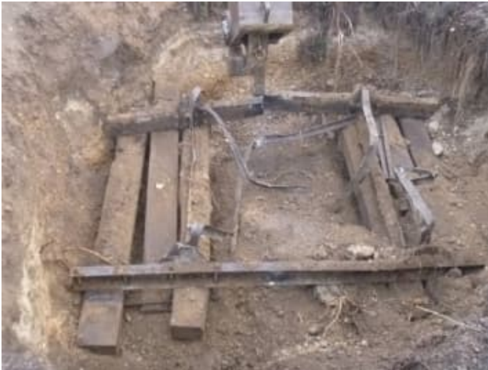
Abbildung 60: Ausbau eines Schwellenfundamentes
