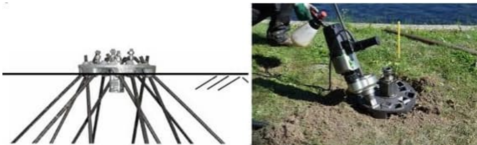
Abbildung 65: Spinnanker, wird mit einem leichten Handwerkzeug eingedreht
