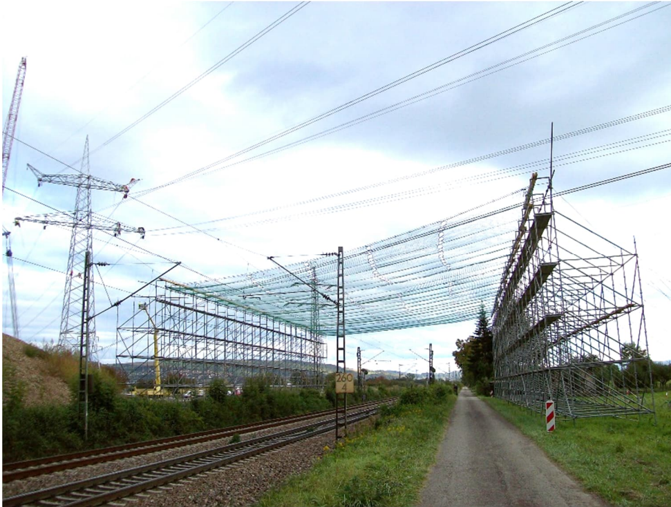
Abbildung 46: Beispiel Schutzgerüst mit Netz an Bahntrasse, Abankerung mit Schraubankern
