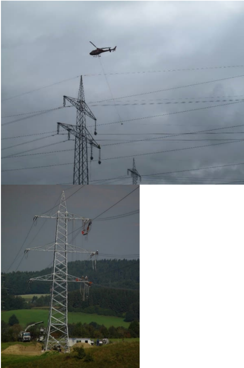
Abbildung 54: Vorseilzug mit Hubschrauber und Seilzugarbeiten
