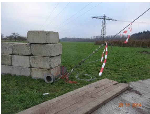
Abbildung 49: Verankerung mit Gewichtsschlitten
