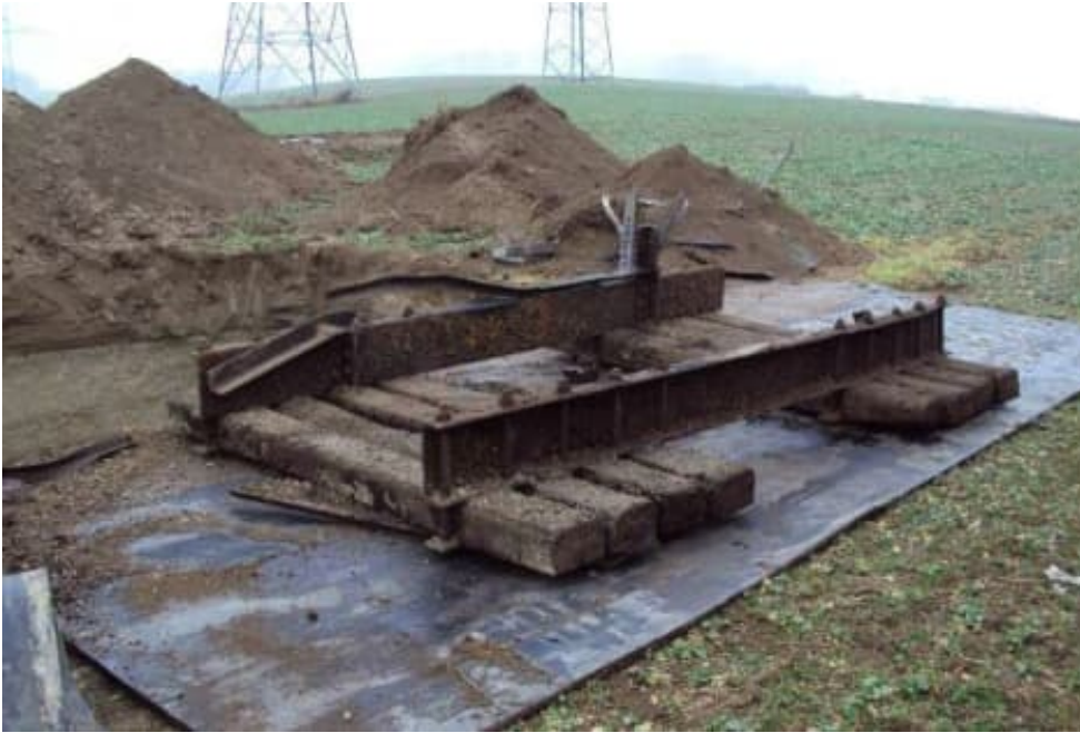
Abbildung 61: Seitlich gelagertes Schwellenfundament vor dem Zerlegen
